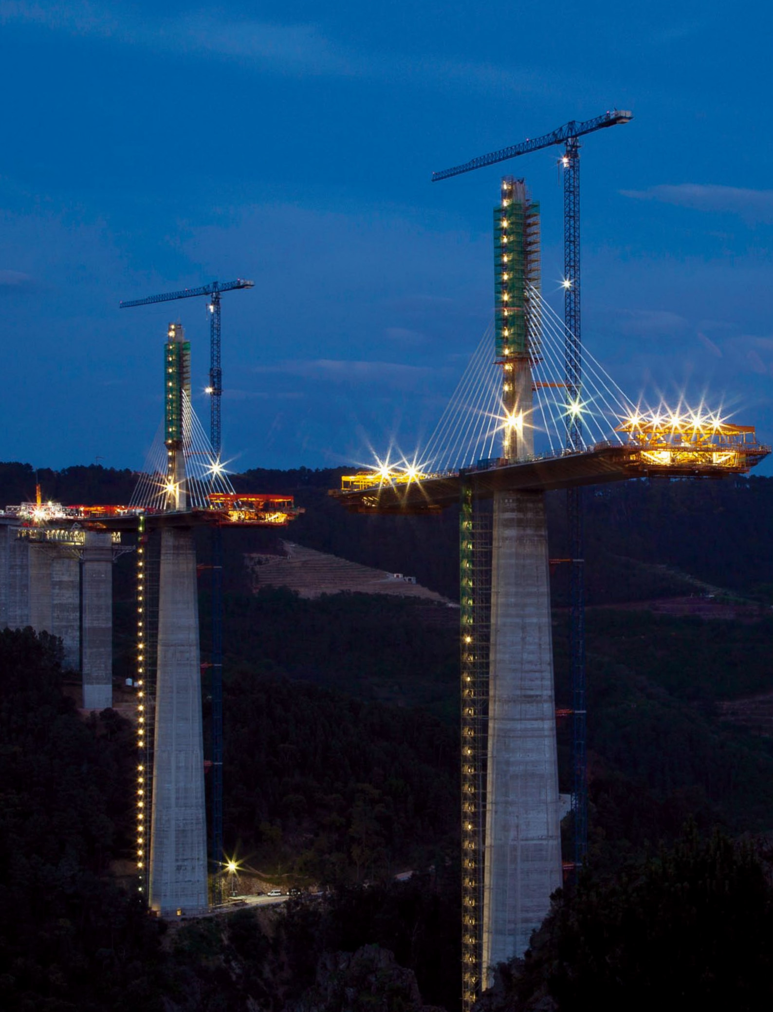
Viaduto sobre o rio Corgo - Autoestrada Transmontana // Viaduct over Corgo's river - Transmontana Motorway Portugal
